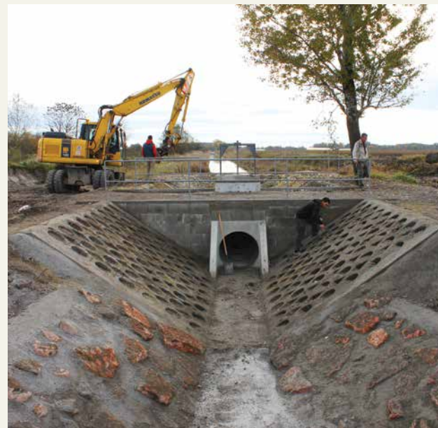
Épül a Dabasi Turjános vízellátását segítő zsilip | Fotó: Gruber Tamás
